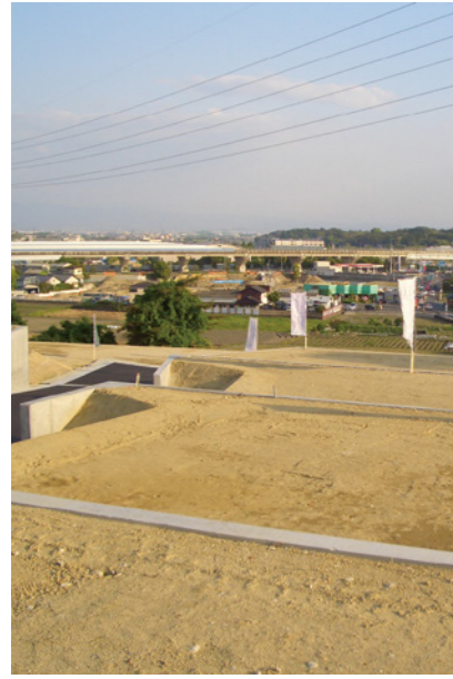
土地造成・土木工事は、同社が最も長く手掛ける分野。災害に備えた安心できる暮らしの基盤を造っている。
